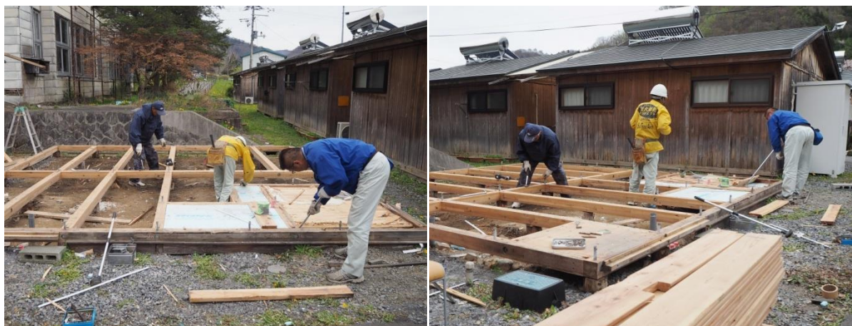
＜払い下げにより移設が決まった仮設住宅の解体作業＞
